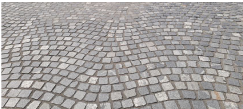
Primer polaganja kock v »valovih« – vzorec 2 (KG2).
