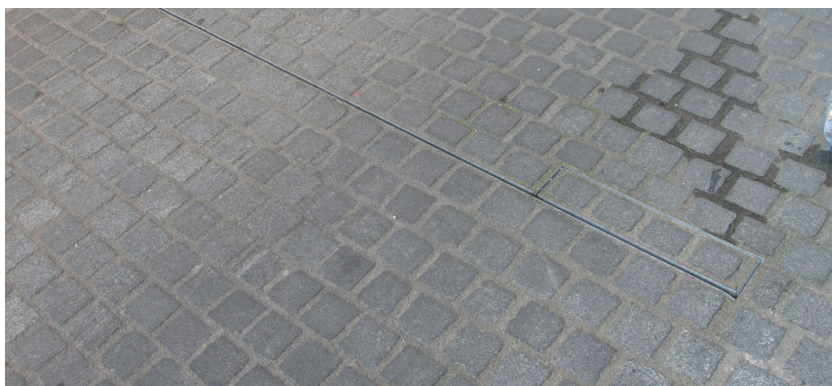
Primer polaganja kock »z zamikom« – vzorec 1 (KG1).
