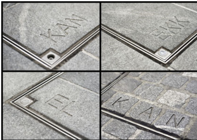
Primer podobne izvedbe pokrovov komunalnih jaškov v Celju.
